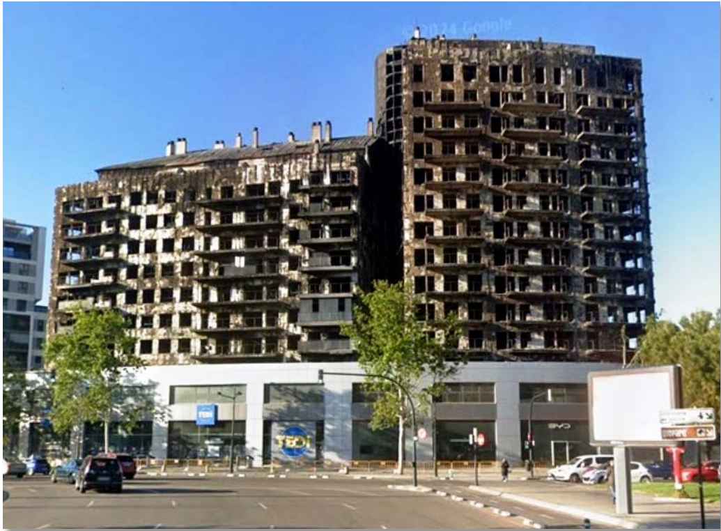
Fachadas delanteras de los dos inmuebles conectados con posterioridad al incendio
