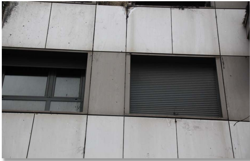
Revestimiento de fachada
